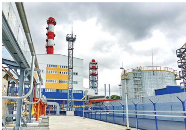
Фото 8. Новая ГТУ-ТЭЦ «Восточная» во Владивостоке
