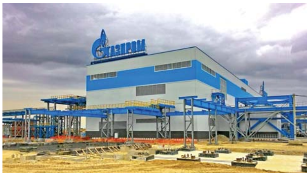
Фото 6. Строящаяся Грозненская ТЭС
