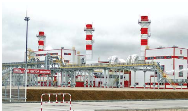
Фото 1. ГТУ-ТЭЦ Ярегского нефтетитанового месторождения
