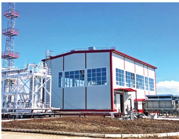
Фото 12. ДКС ангарного типа размещается в отдельном капитальном здании
